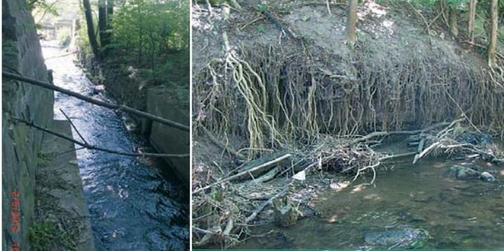
oben links: der nur 2 Meter breite Betonkanal bildet eine gefährliche Engstelle; oben rechts: unterstülpte Bäume als zusätzliches Risiko; rechts: die alten Gemäuer trotz der Schwerkraft. Wenn die Mauer jedoch fällt, rutschen Gesteinsmassen und Bäume in den Bach.
