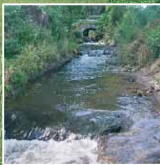
Stufen zur Reduzierung der Fließgeschwindigkeit und Stabilisierung der Bachsohle
